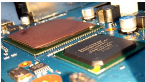
Solda inacessível Componente (BGA)
