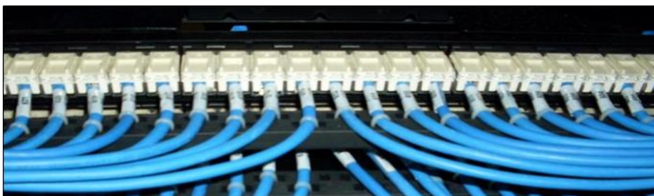
Fixação CORRETA dos cabos UTP no guia do Patch Panel
