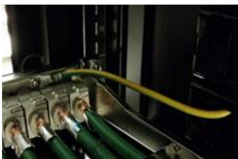
Aterramento do Patch Panel no Rack
