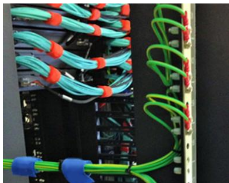
Aterramento CORRETO de equipamentos no Rack
