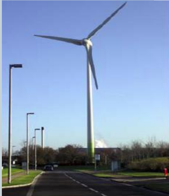
a) Vento – Energia Eólica
