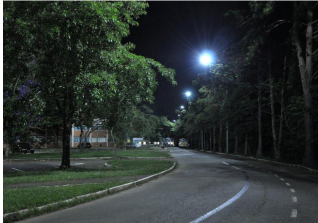
Figura 5.3 – Foto do trecho após a instalação do sistema LED
