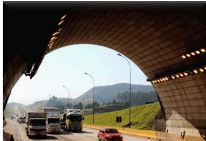
Figura 5.4 – Trecho de túnel do Rodoanel com iluminação a vapor metálico
