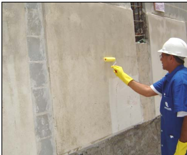
Figura 39 - Aplicação do fundo preparador de superfícies
