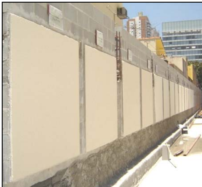
Figura 51 - Painéis com pintura texturizada acrílica
