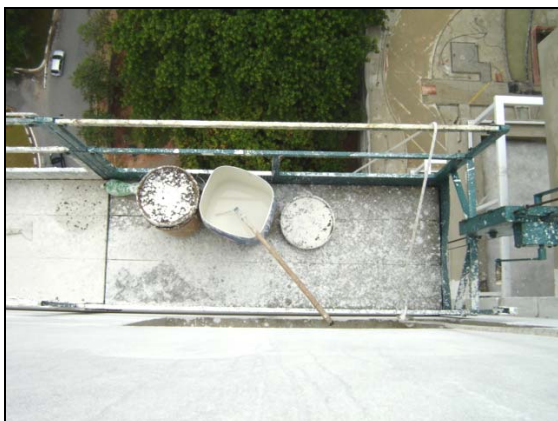
Figura 28 - Tinta texturizada no andaime
