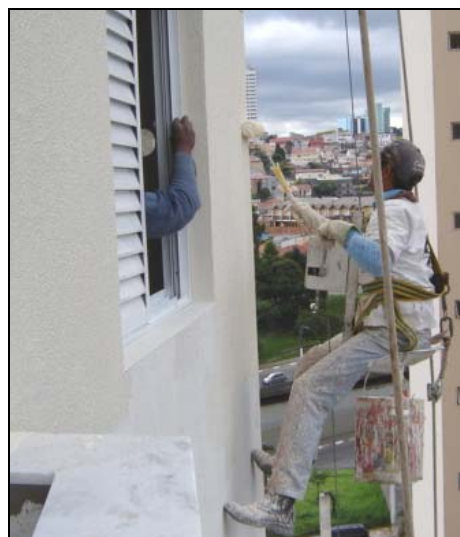
Figura 21 - Detalhe da aplicação
