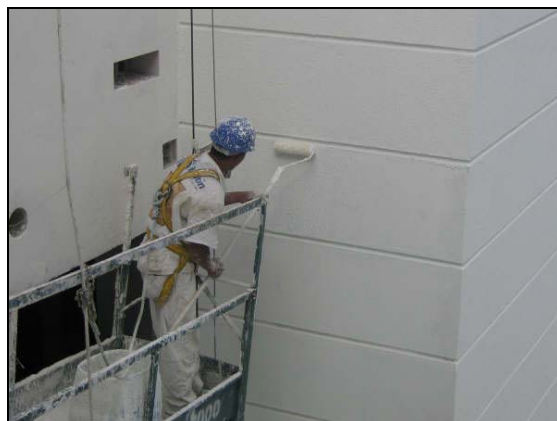
Figura 29 - Aplicação da tinta texturizada
