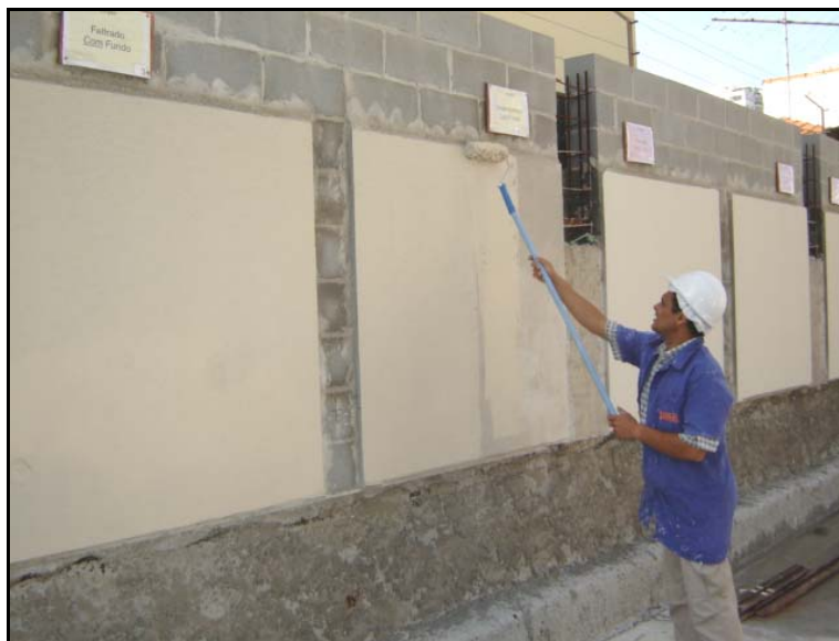
Figura 44 - Aplicação de selador (Fornecedor A)
