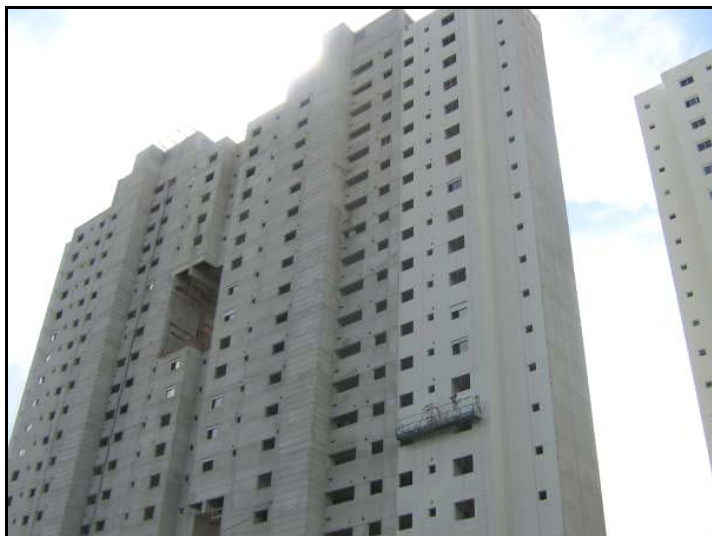
Figura 26 - Aplicação de selador
