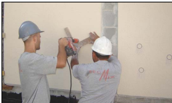
Figura 54 - Execução do corte
