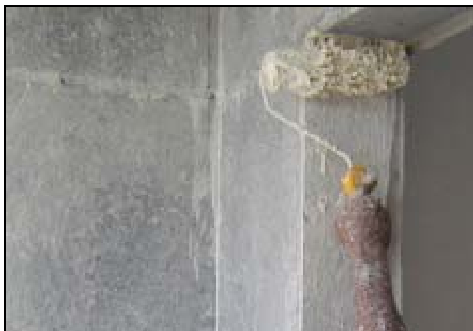
Figura 15 - Aplicação do selador
