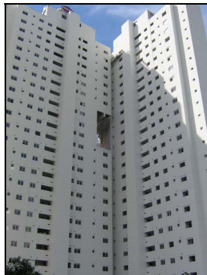
Figura 27 - Fachada com selador
