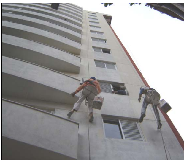
Figura 20 - Aplicação da tinta texturizada
