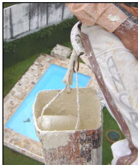
Figura 19 - Fixação na cadeira suspensa
