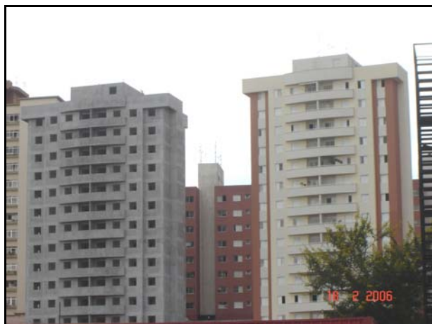
Figura 12 - Fachadas – Bloco A e B
