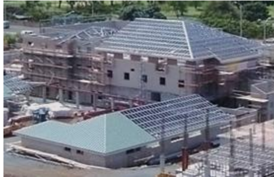
Foto 3 - Estrutura de telhado em LSF com cobertura em telhas metálicas
