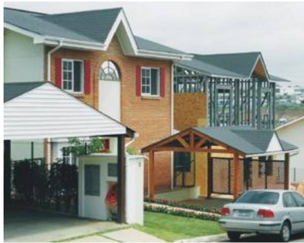
Foto 4 - Casas construídas com o sistema LSF em Cotia (SP)
