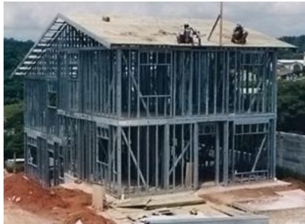
Foto 1 - Estrutura de residência em light steel frame
