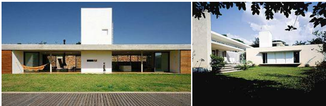
Foto 1 – residência em Joanópolis. UNA Arquitetos. Fonte: Revista PROJETODESIGN. Ed. 343 Setembro de 2008. Foto 2 – residência em São Paulo. Marina Grinover Arquitetura e Piratininga Arquitetos Associados. Projeto de 1999. Fonte: Marina Grinover e Piratininga Arquitetos. Residência, São Paulo-SP. Casa a quatro mãos. Revista PROJETODESIGN. Edição 264 Fevereiro de 2002
